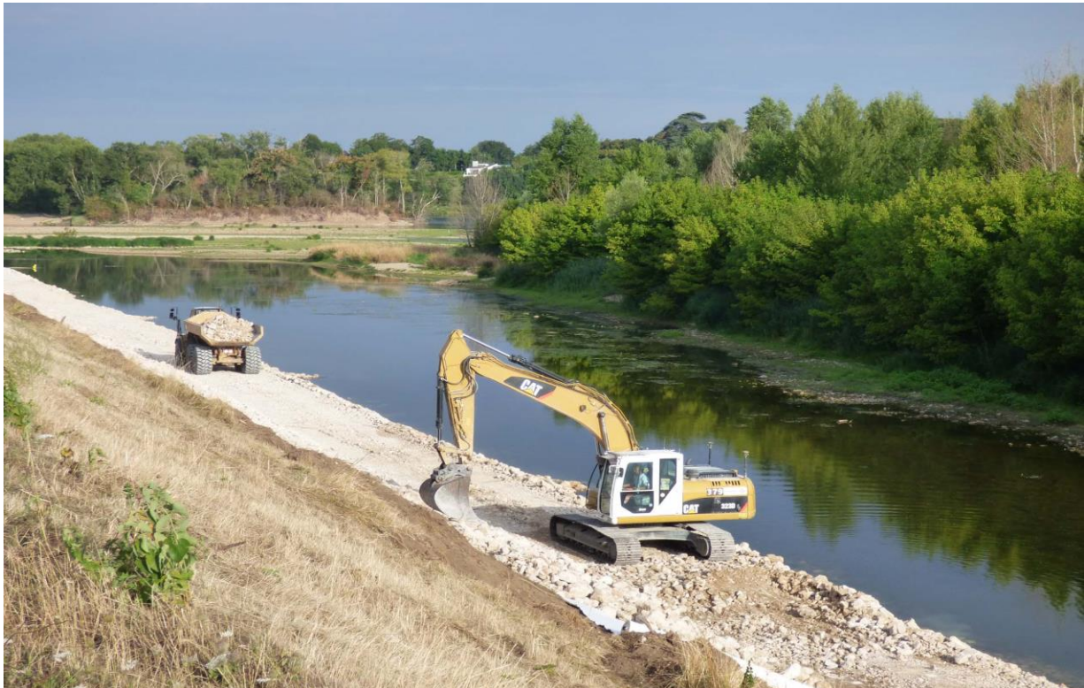
Figure 20 : Travaux de renforcement de la levée à Mareau-aux-Prés
